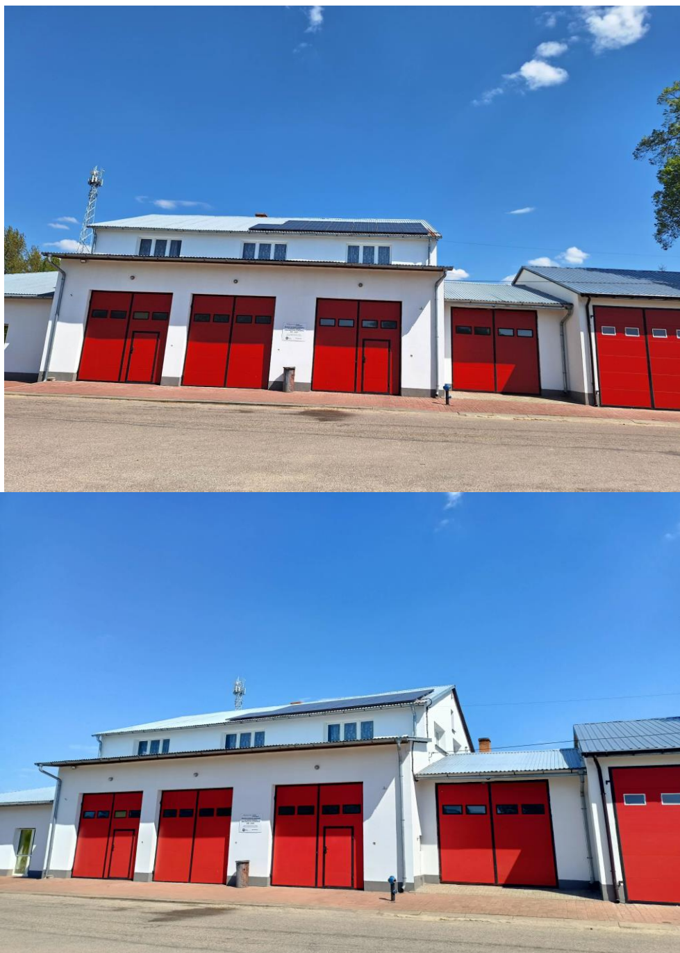
Instalacja fotowoltaiczna na budynku Ochotniczej Straży Pożarnej w Lipnie
